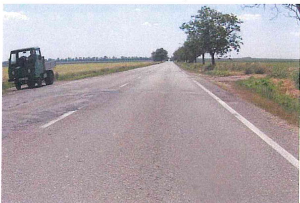
HL. koroze, mozaikové trh., příčná trh., vysprávký
