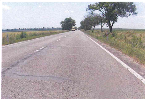
HL. koroze, podélná trh., příčné trh., vysprávký
