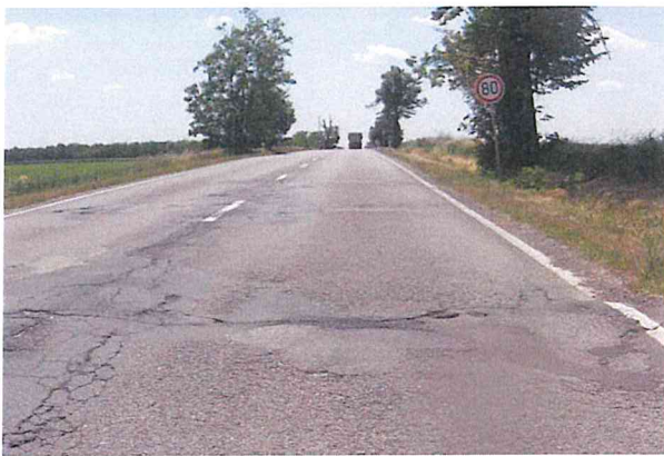
Hl. koroze, výtluky, mozaikové trhliny, vysprávký
