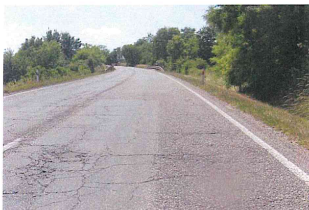
Hlubková koroze, mozaikové trhliny, vysprávk
