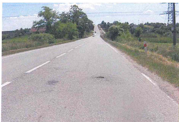
Hl. koroze, výtluk, mozaikové trhliny, vysprávka
