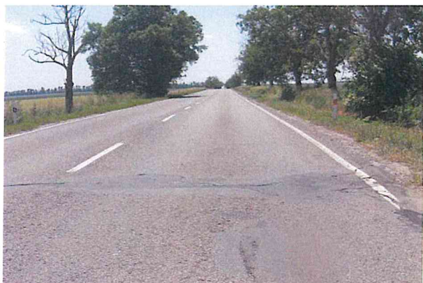
Hlubková koroze, příčná trhлина, vysprávký
