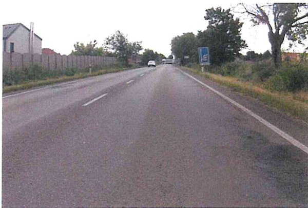
Hlubková koroze, mozaikové trhliny, vyjeté koleje
