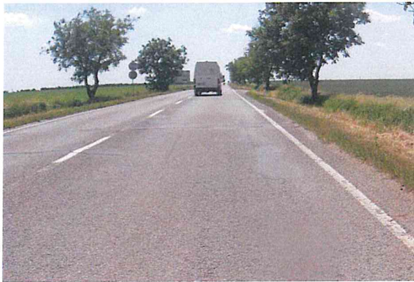
Hl. koroze, příčné trhliny, vysprávký
