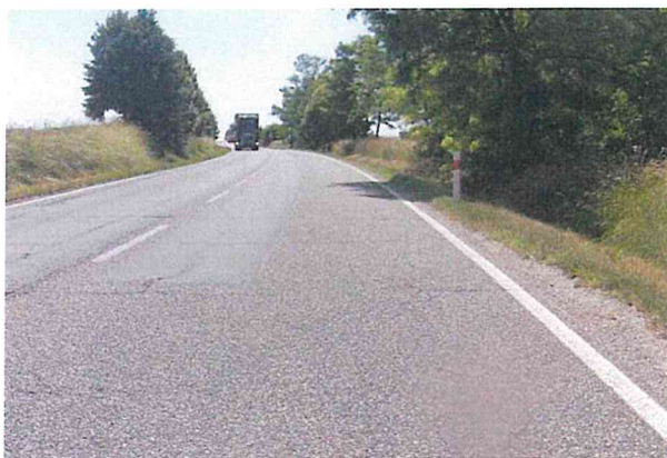
Hlubková koroze, mozaikové trhliny, vysprávk
