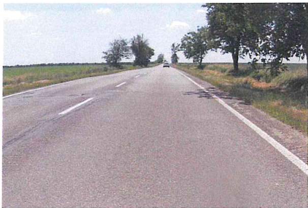
Výtluk, podélná rozvětvená trhlina, příčná trhlina
