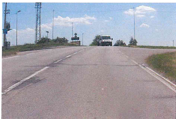
Mozaikové trh., příčné trh., vysprávky, vyjeté koleje
