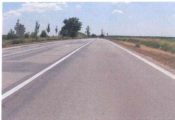
Konec úseku, podélná trhlina, vysprávkky
