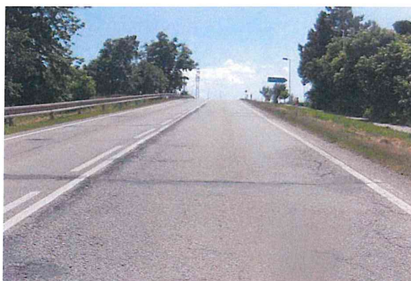
Hl. koroze, mozaikové trhliny, vysprávky,
