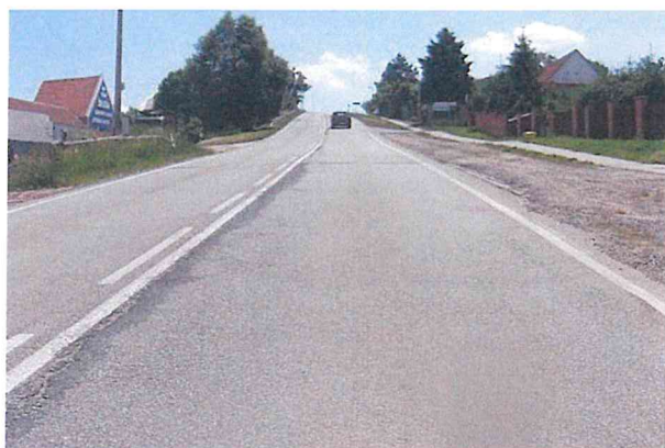
Podélná rozvětvená trhlina, příčná trhlina, vysprávka
