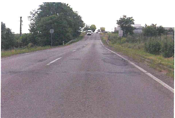
Hl. koroze, příčné trhliny, vysprávk, vyjeté koleje
