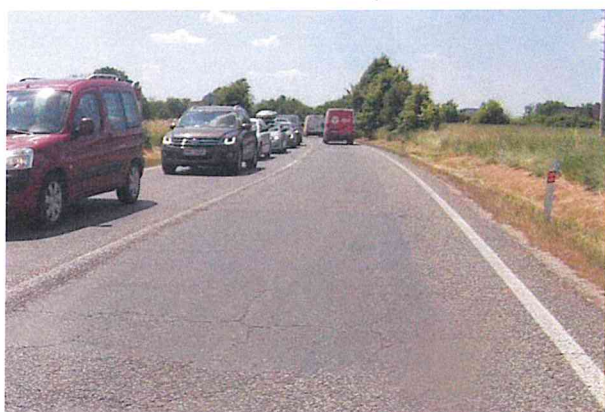
Začátek úseku, mozaikové trhliny
