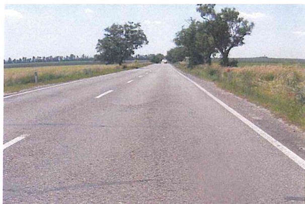
HL. koroze, mozaikové trhliny, příčné trhliny
