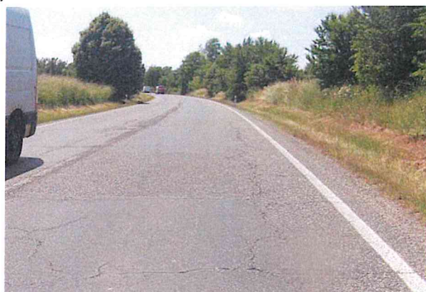
Hlubková koroze, mozaikové trhliny, vysprávk
