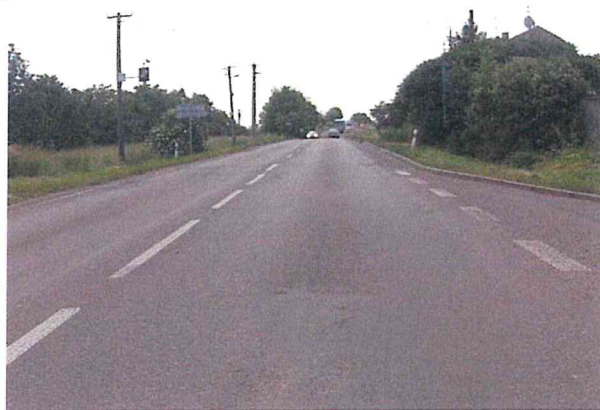
Hlubková koroze, podélná trhlina, vyjeté koleje
