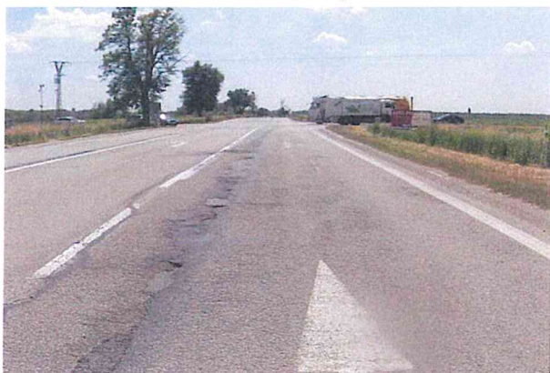
Hl. koroze, výtluky, mozaikové trhliny, vysprávkky
