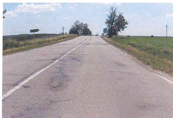
Hl. koroze, mozaikové trhliny, vysprávky
