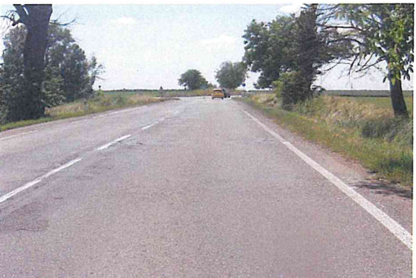
Hl. koroze, výtluk, mozaikové trhliny, vysprávký
