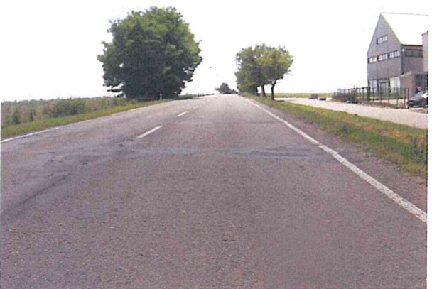
Hlubková koroze, příčné trhliny, vysprávk
