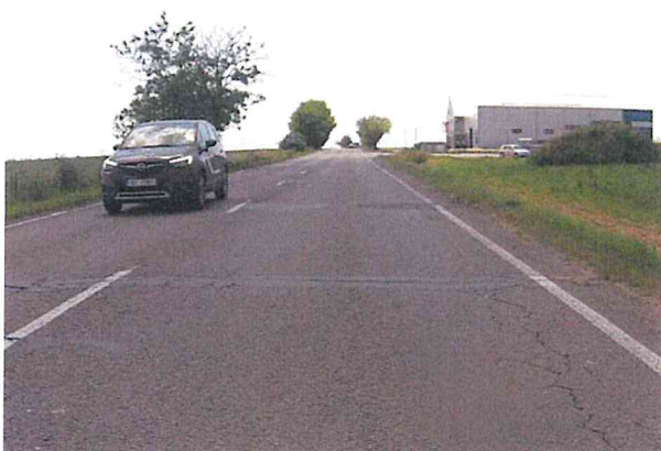
Hl. koroze, mozaikové a příčné trhliny, vysprávk
