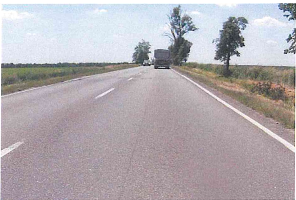
Příčná trhlina, vyjeté koleje
